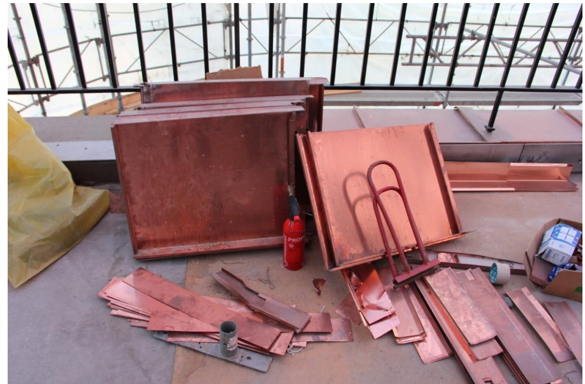
Fine kobberdetaljer på taget bankes på plads.
