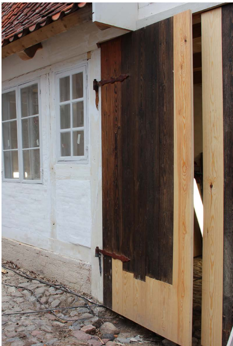
Staldbygningen havde råd i konstruktionen, men har fået reparationer, der smelter flot sammen.
