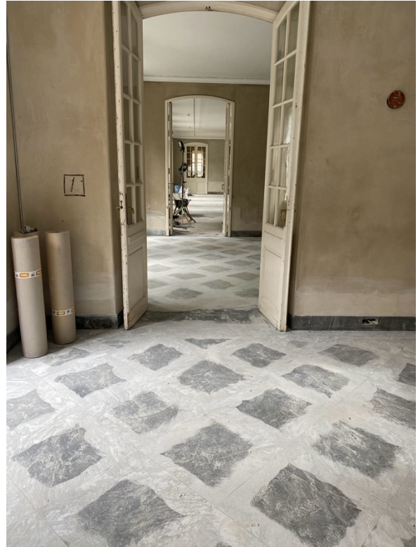
Slibning af det nylagte gulv i rum 12, 11 og 10 i østfløjen er påbegyndt.
