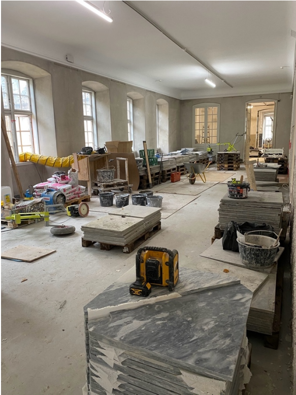
Der gøres klar til flisebelægning i rum 16 (sydføj)
