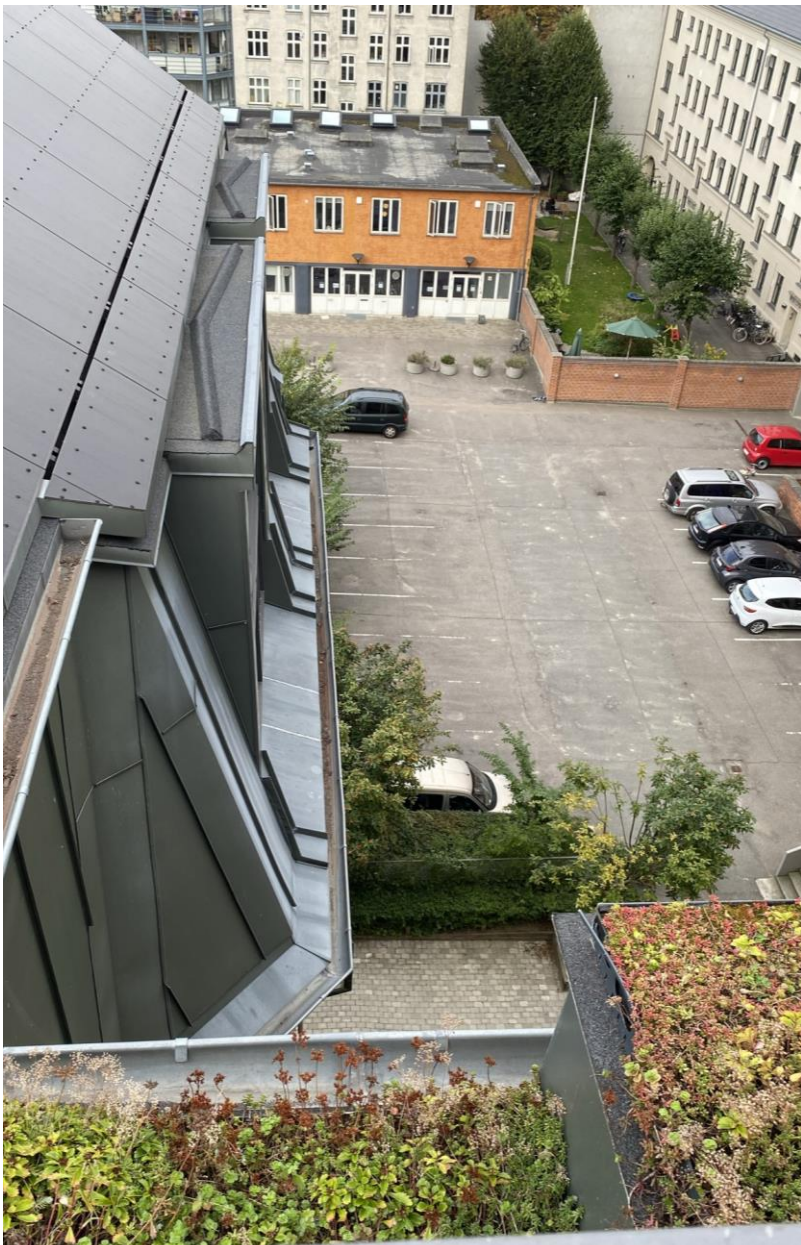
I renoveringen af Ryesgade 25 har der været fokus på at spare energi og forbedre indeklimaet med bl.a. nye vinduer, indvendig isolering, balanceret ventilation med varmegenvinding og nyt tag med solceller, der bidrager positivt til energiregnskabet.
