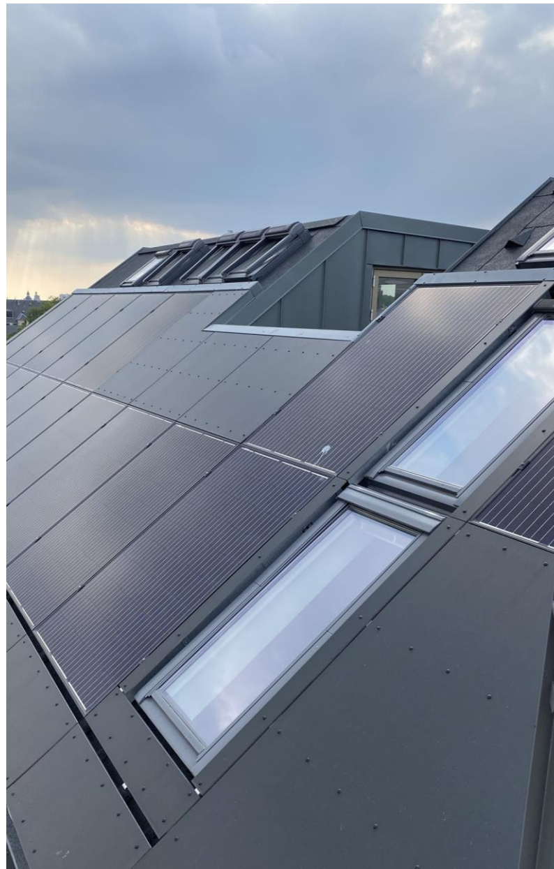
I renoveringen af Ryesgade 25 har der været fokus på at spare energi og forbedre indeklimaet med bl.a. nye vinduer, indvendig isolering, balanceret ventilation med varmegenvinding og nyt tag med solceller, der bidrager positivt til energiregnskabet.
